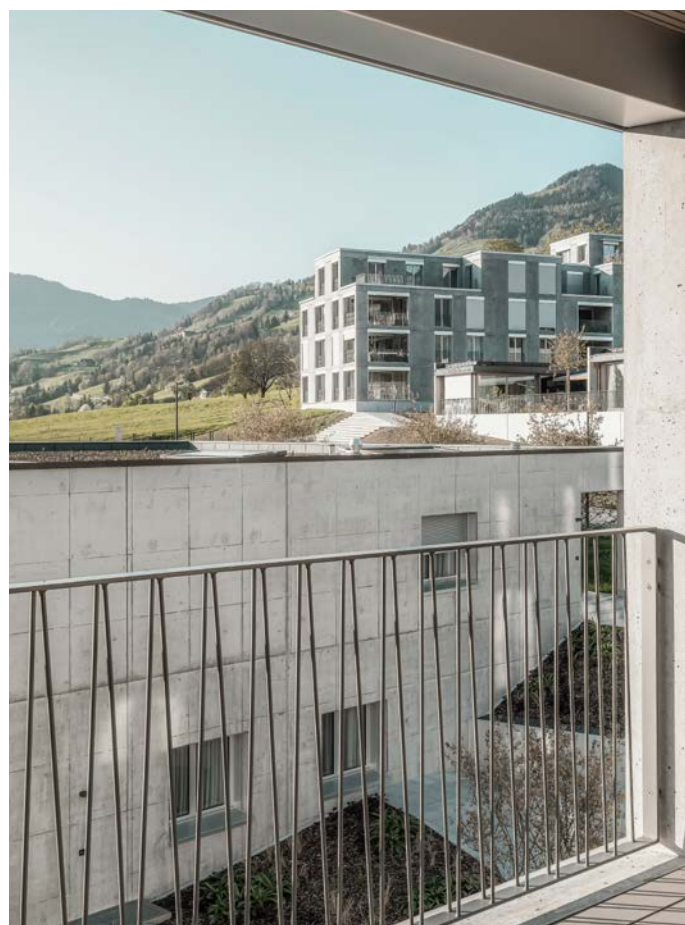
■ Siedlung Mättivor in Schwyz mit intelligenter Steuerung aller Energieerzeuger und -verbraucher.
